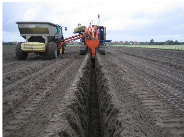
Afbeelding 4. Drainage-aanleg door sleuven.
