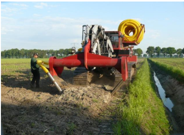
Afbeelding 3. Sleufloze aanleg van drainage.
